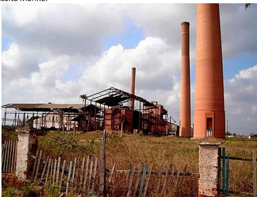
O parque industrial de Cambahyba, em Campos: corpos chegavam para serem incinerados. Foto: Divulgação/Gabinete da deputada Marina do MST
