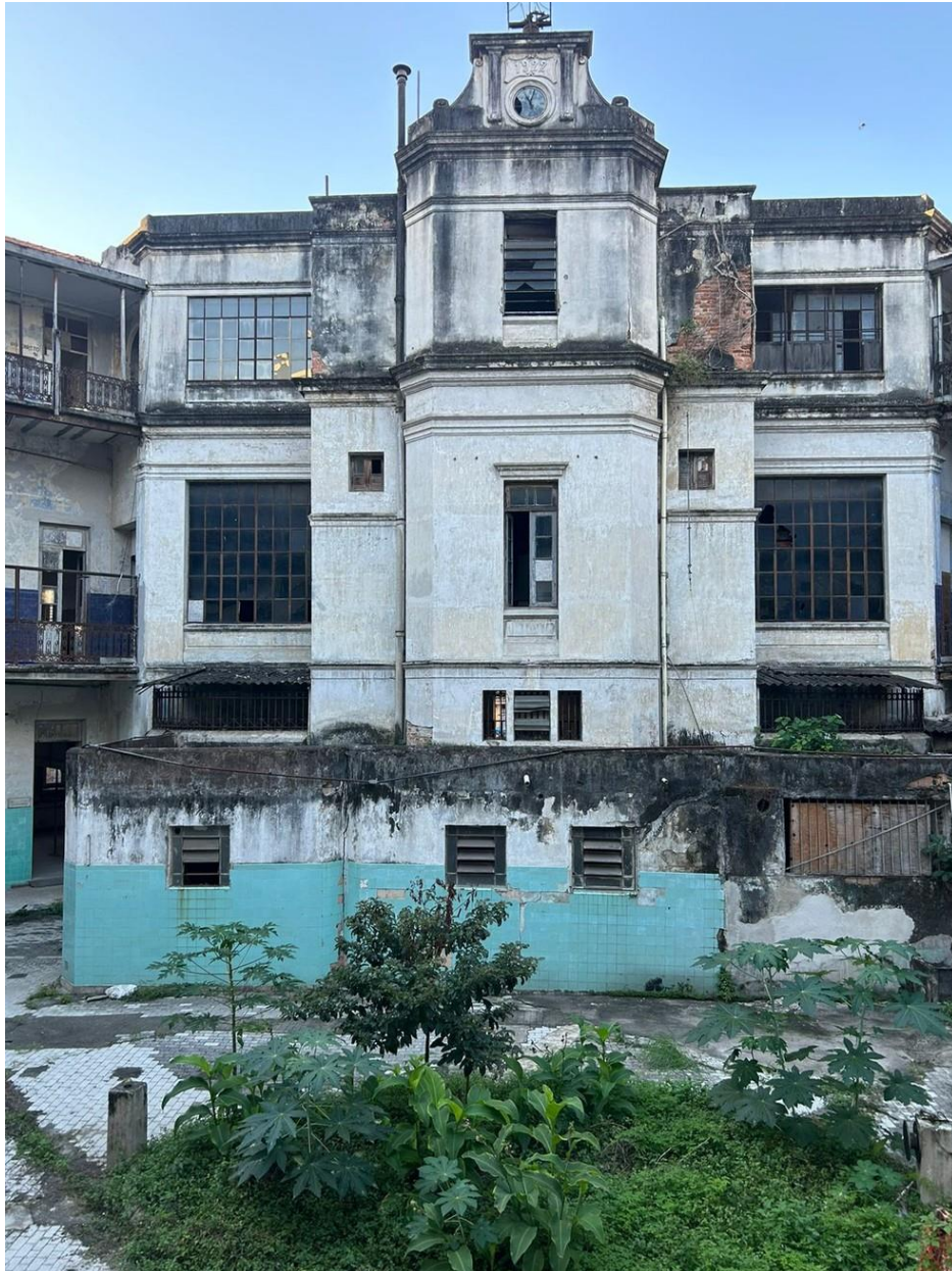
Prédio do Dops, na Rua da Relação, no Centro do Rio: má conservação.
