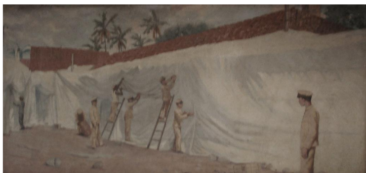
Isolando habitação para expurgo de mosquitos
